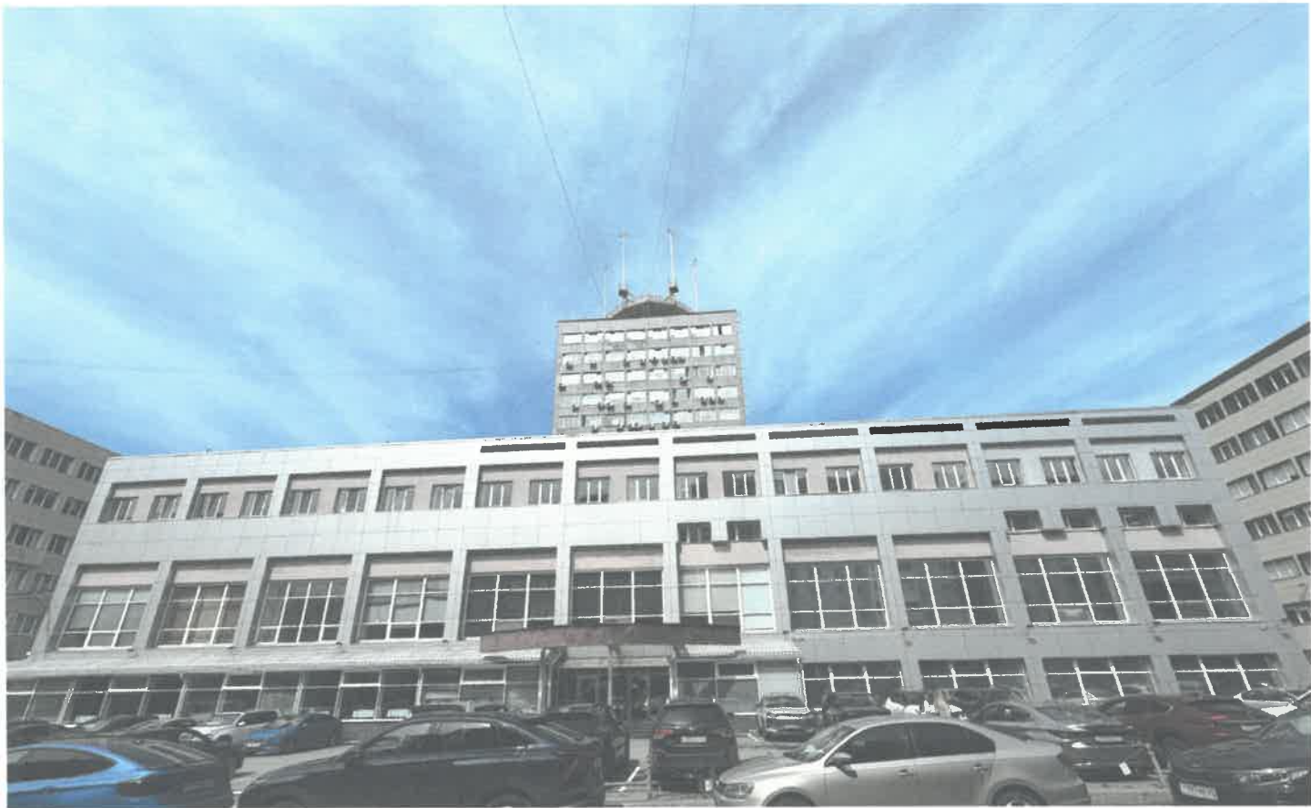
Главный фасад со стороны ул. Пермской
