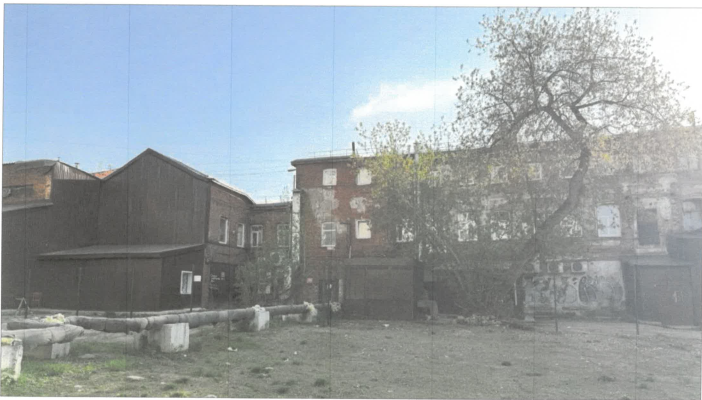
Дворовой фасад в осях 5-1
