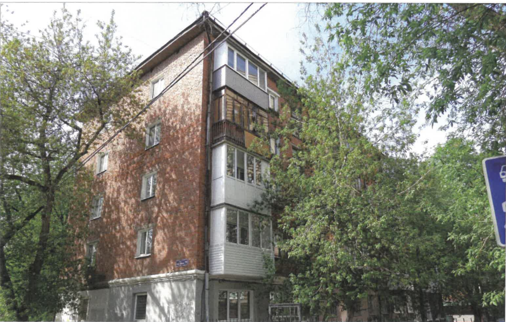
Главный фасад по ул. Клары Цеткин
