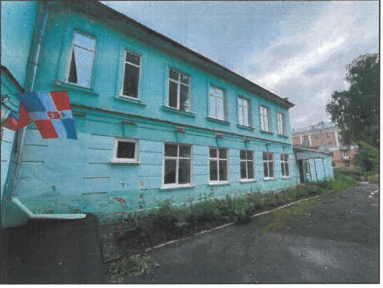
Фасад в осях Б-Е
