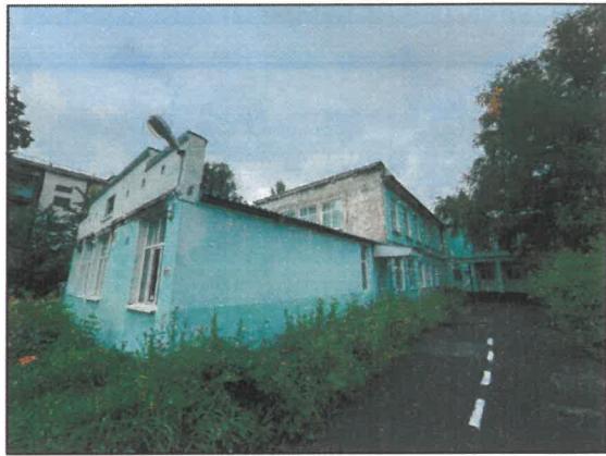
Фасад в осях Е-Б
