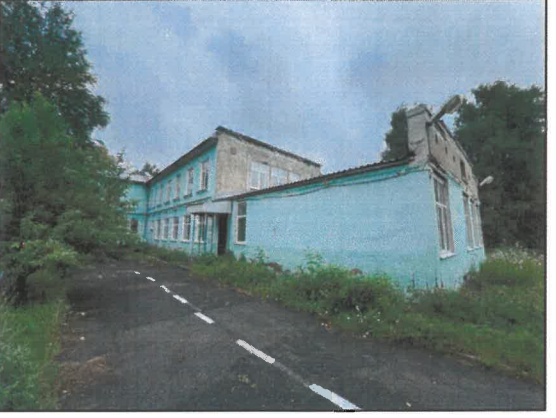
Фасад в осях Б-Е
