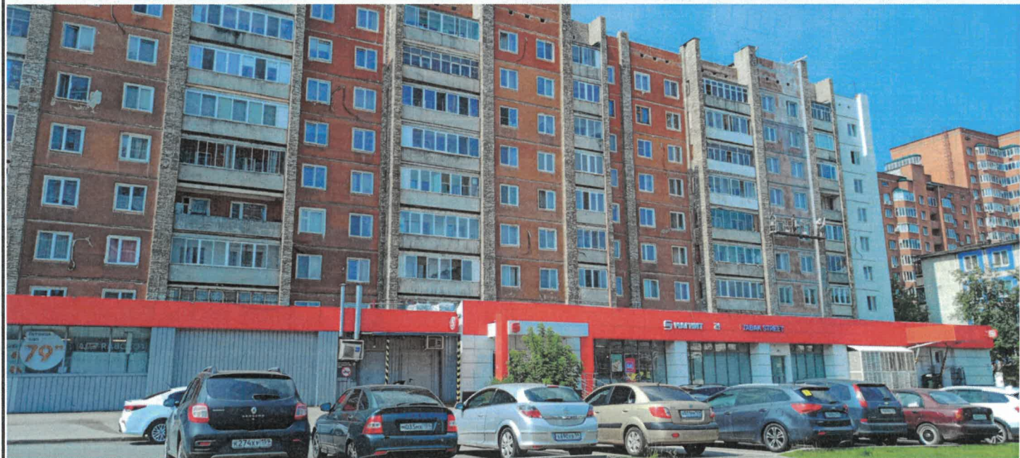
Фрагмент главного фасад в осях 1-2 по ул. Крисанова (фотофиксация)
