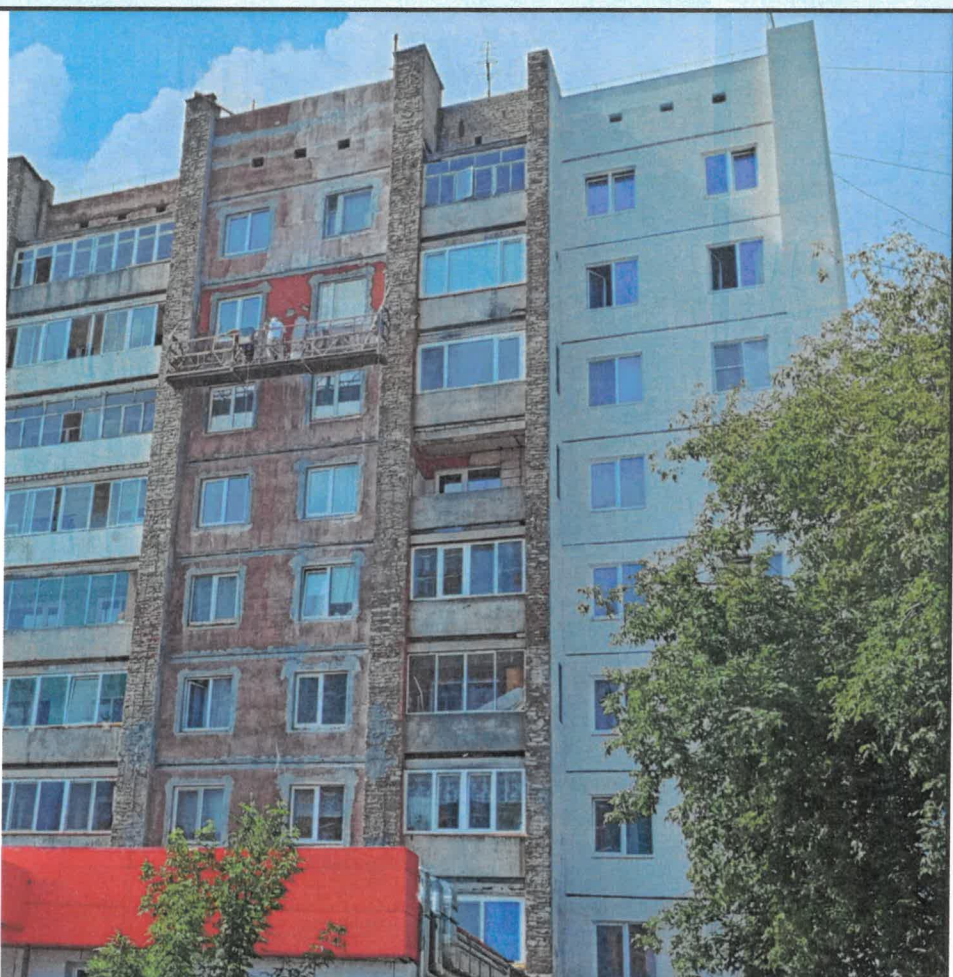
Фрагмент главного фасад в осях 1-2 по ул. Крисанова (фотофиксация)
