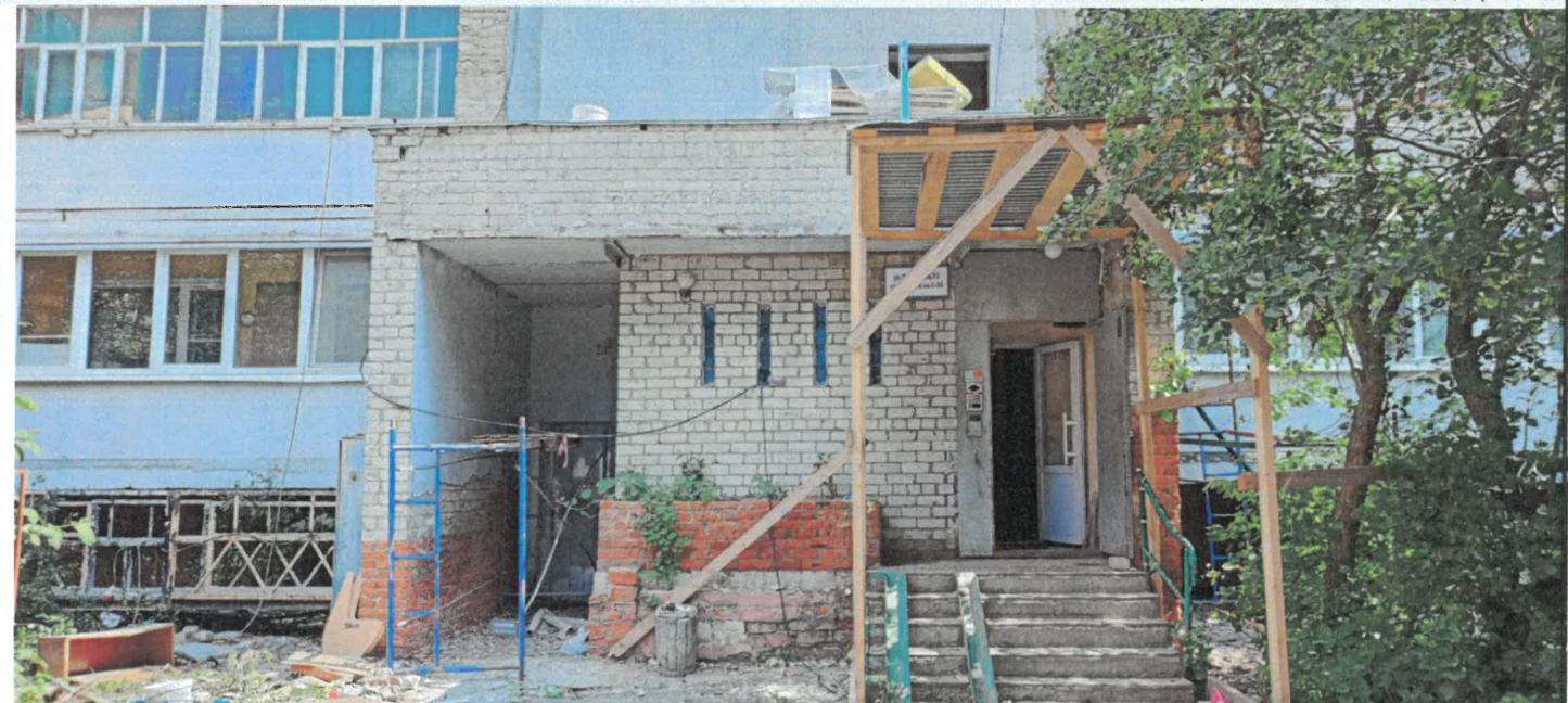
Фрагмент дворового фасад в осях 2-1 (фотофиксация)
