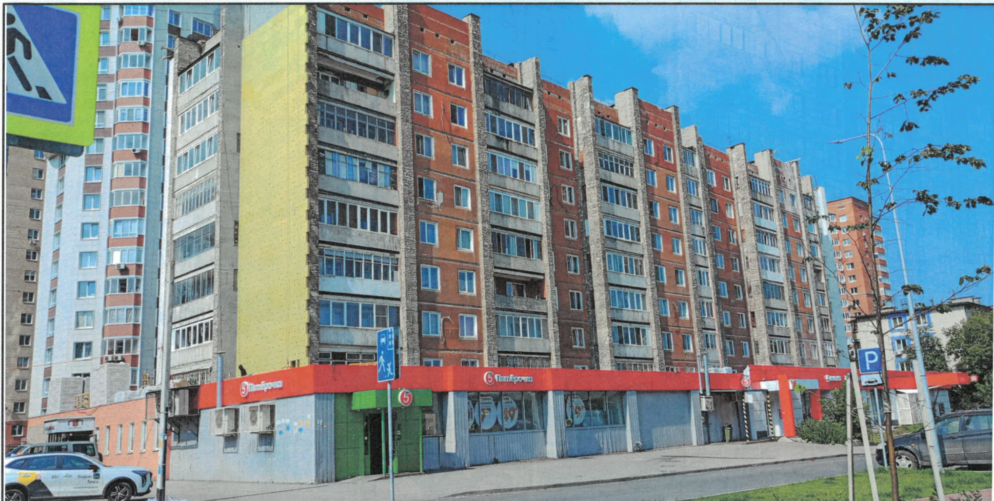
Вид на главный фасад в осях 1-2 по ул. Крисанова и боковой фасад Б-А по ул. Данилихинская (фотофиксация)
