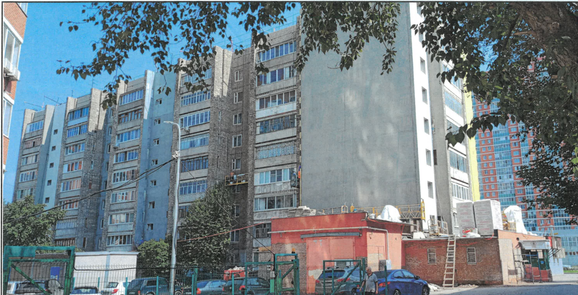
Вид на дворовой фасад в осях 2-1 и боковой фасад Б-А по ул. Данилихинская (фотофиксация)
