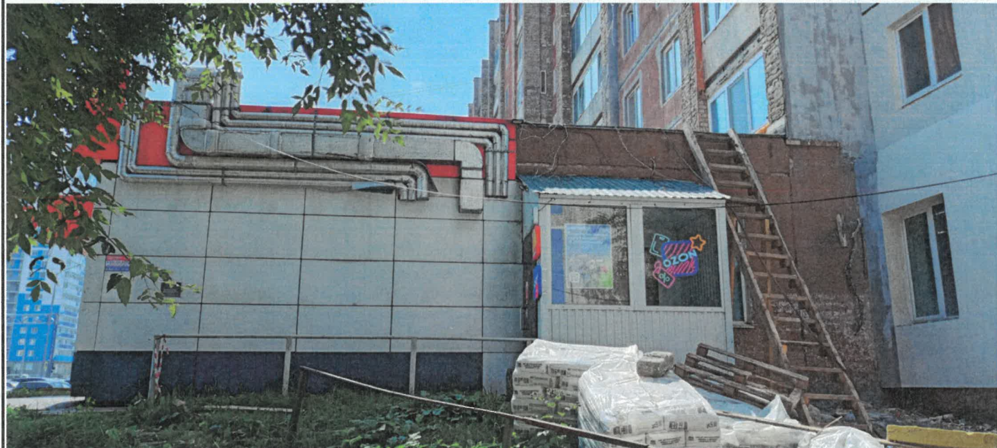
Фрагмент бокового фасада в осях А-Б (фотофиксация)
