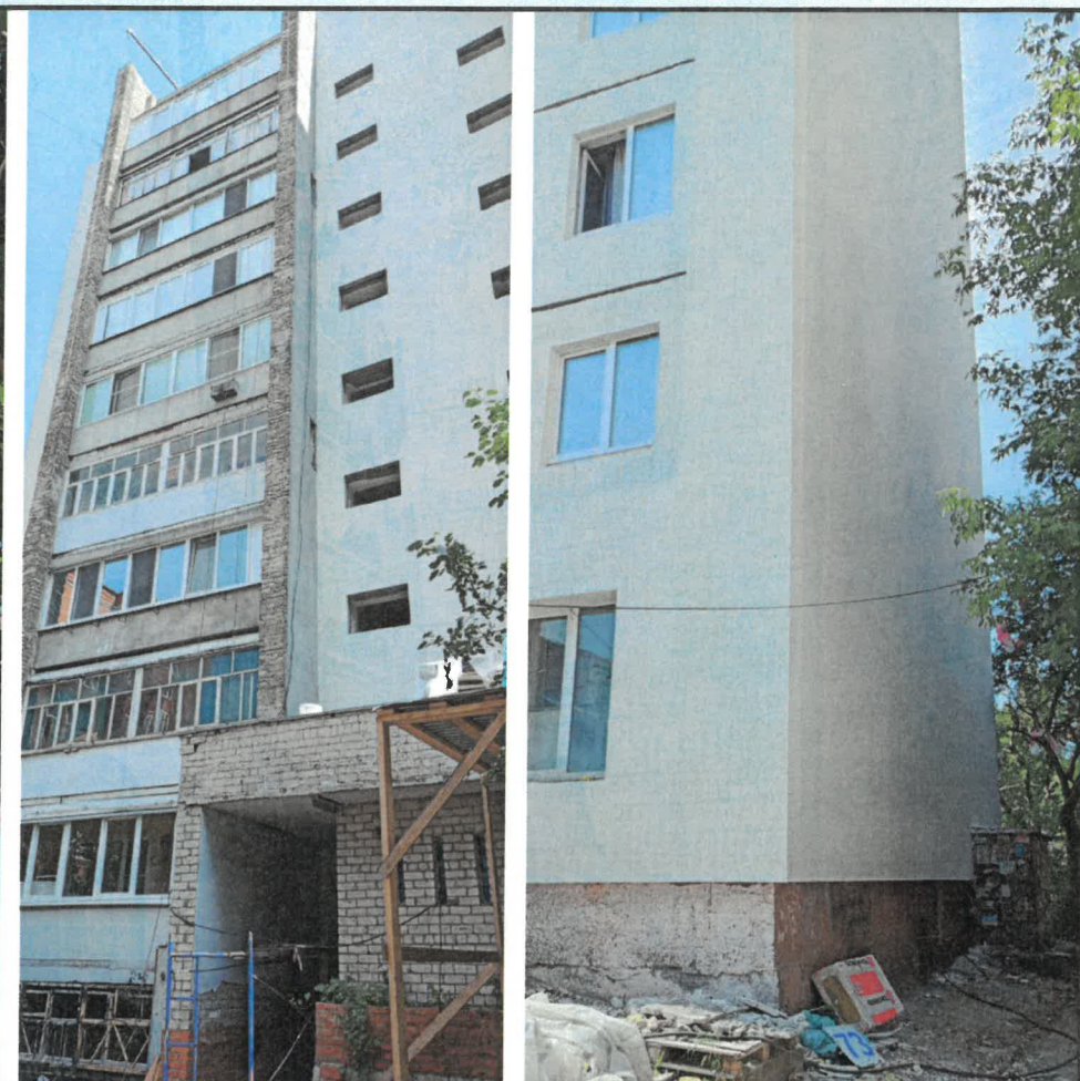
Фрагмент дворового фасад в осях 2-1, фрагмент бокового фасада А-Б (фотофиксация)
