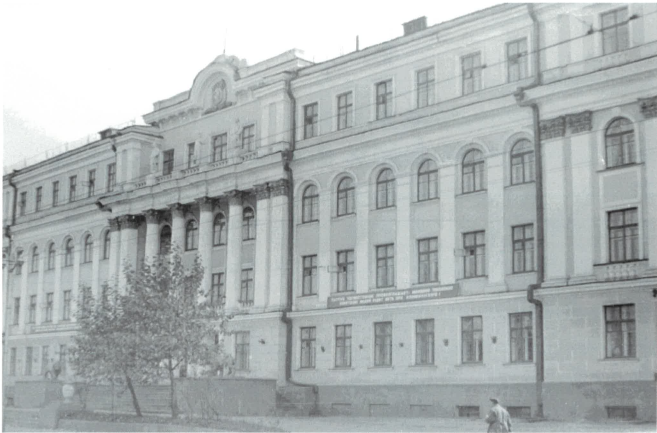
Главный фасад, 1961 г.
