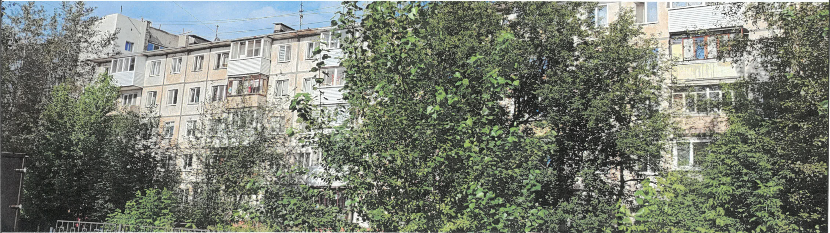
Фрагмент бокового фасада в осях 2-1 (фотофиксация)
