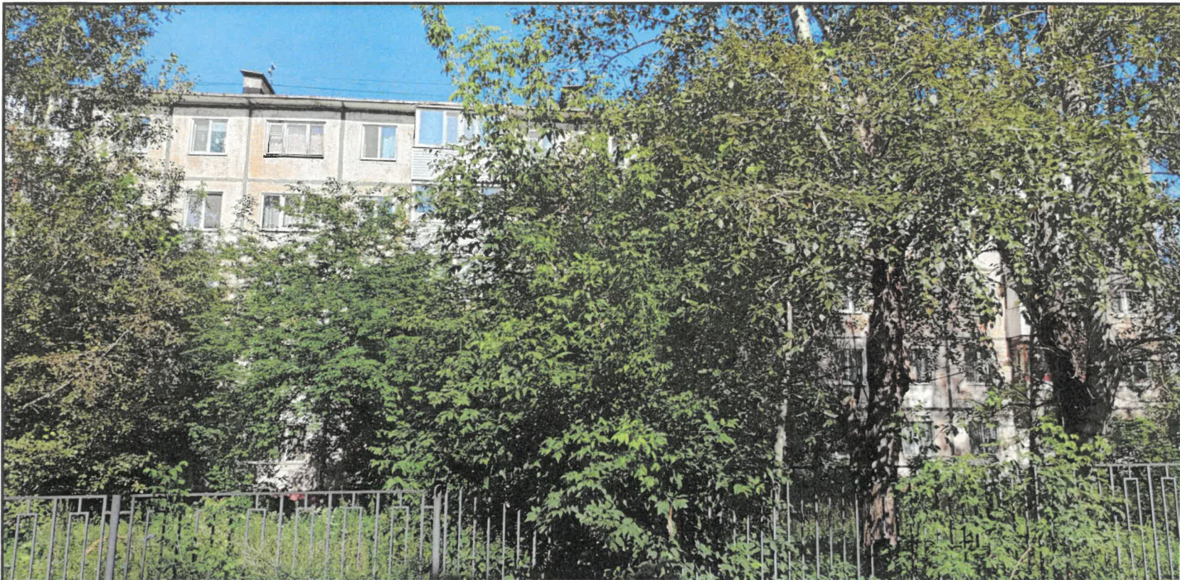
Фрагмент бокового фасада в осях 2-1 (фотофиксация)
