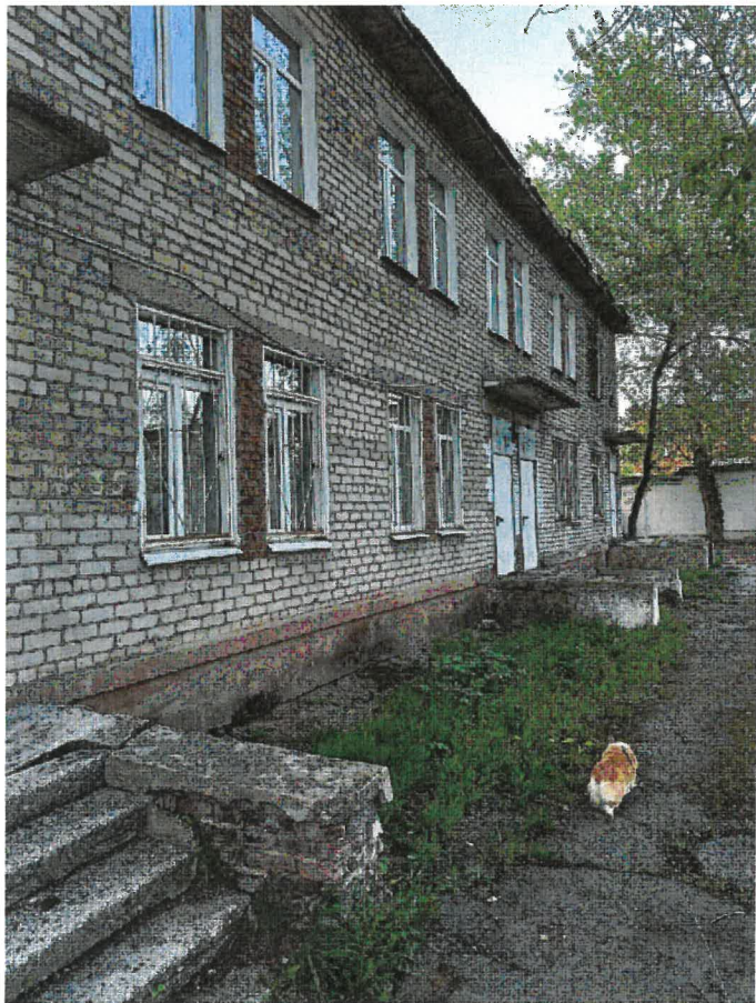
Фрагмент главного фасада
