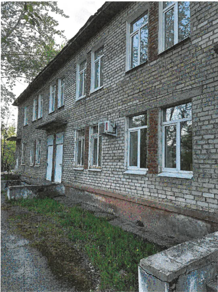
Фрагмент главного фасада
