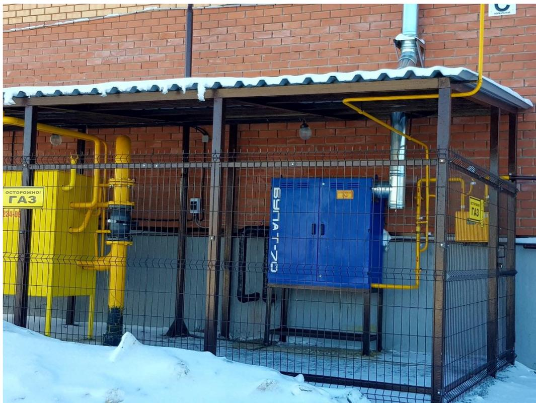
**Рисунок 57 – Внешний вид конденсационных котлов наружного размещения на фасаде.**
