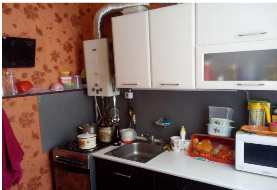
**Рисунок 49 – Размещение газовых колонок в квартирах**
