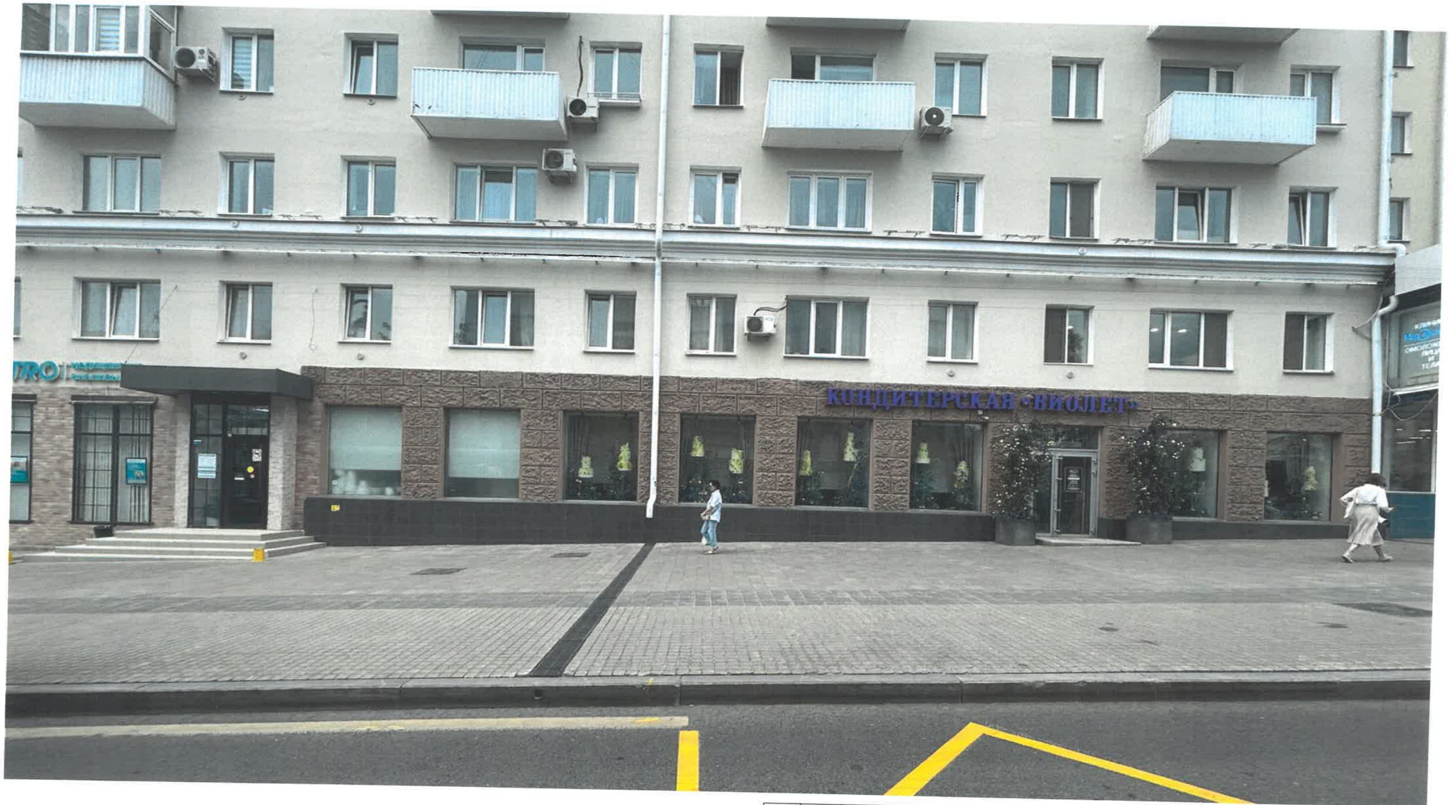
Фотофиксация места установки сезонного (летнего) кафе 04.06.24г.
