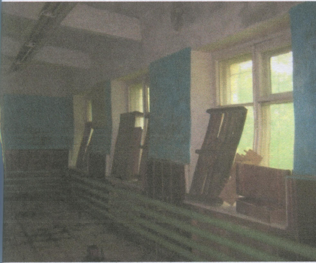
Здание мастерских (лит. Б)
