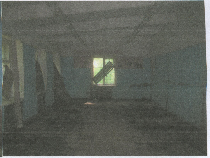
Здание мастерских (лит. Б)
