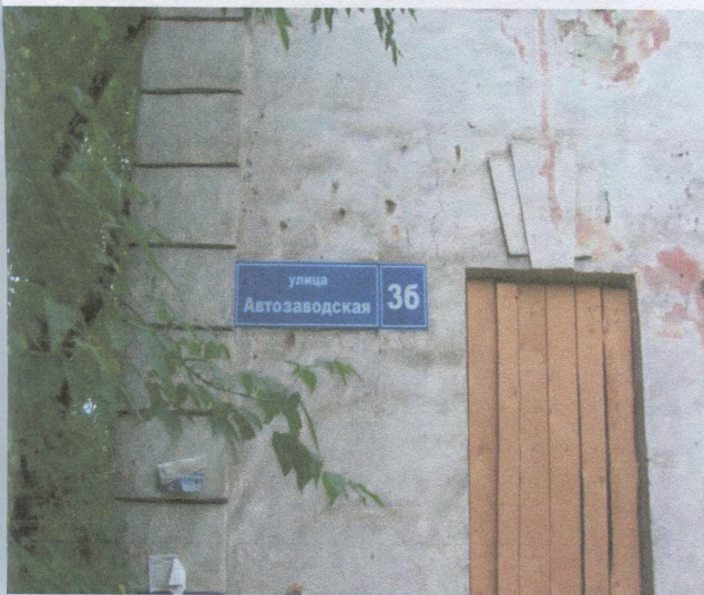
Жилой дом, адрес
