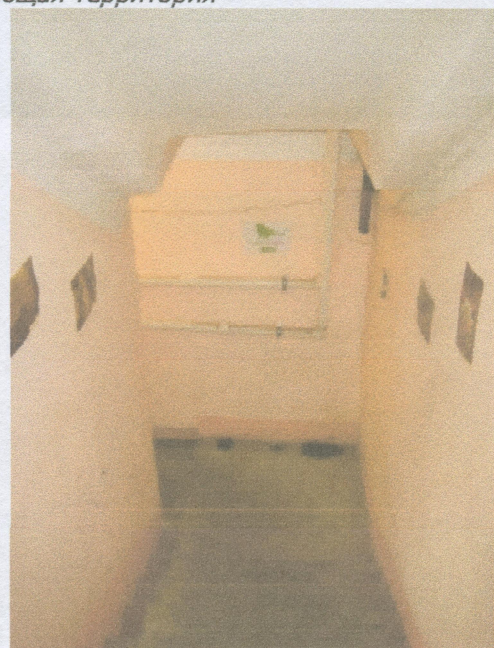
Вход в оцениваемые помещения
