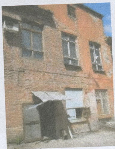
Здание и прилегающая территория, по адресу Ким, д. 93
