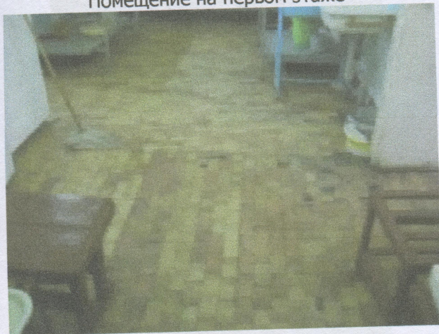
Помещение на первом этаже
