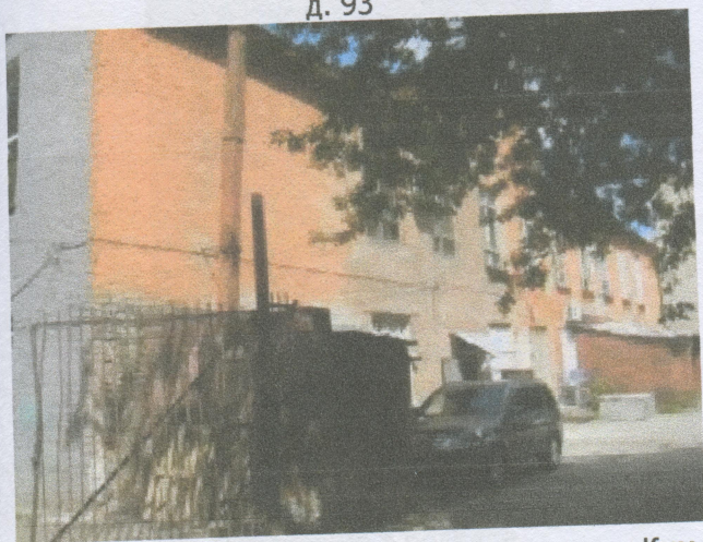
Здание и прилегающая территория, по адресу Ким, д. 93
