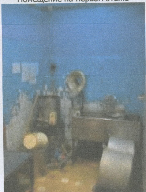
Помещение на первом этаже
