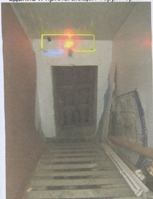
Спуск в подвал
