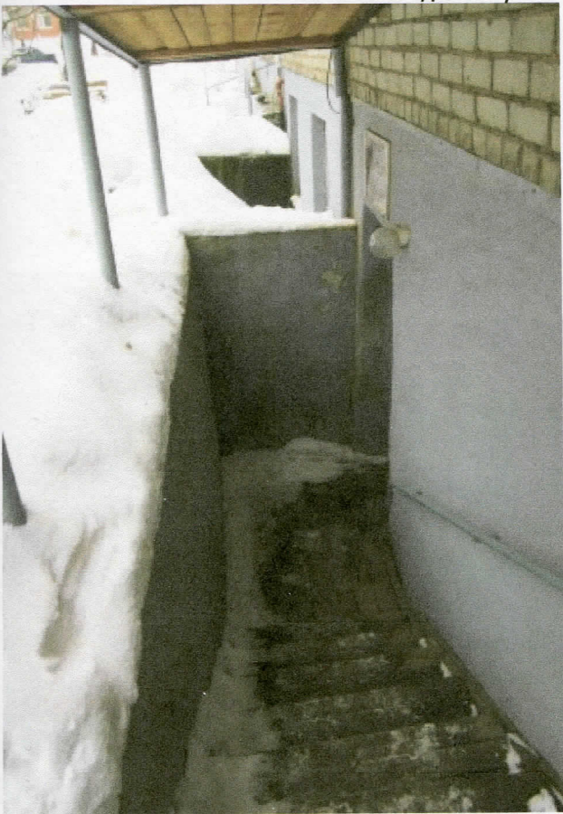
Вход №1 в нежилое помещение
