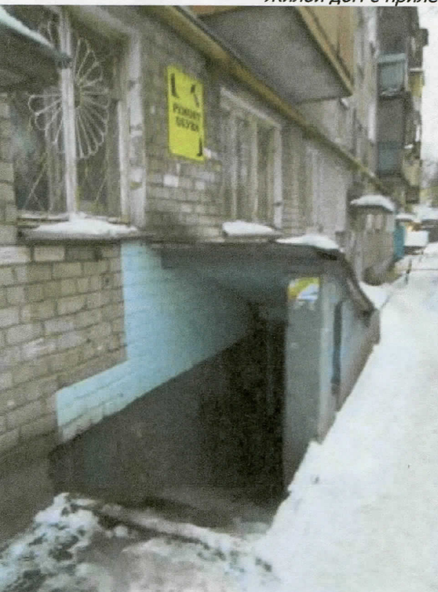
Вход в нежилое помещение
