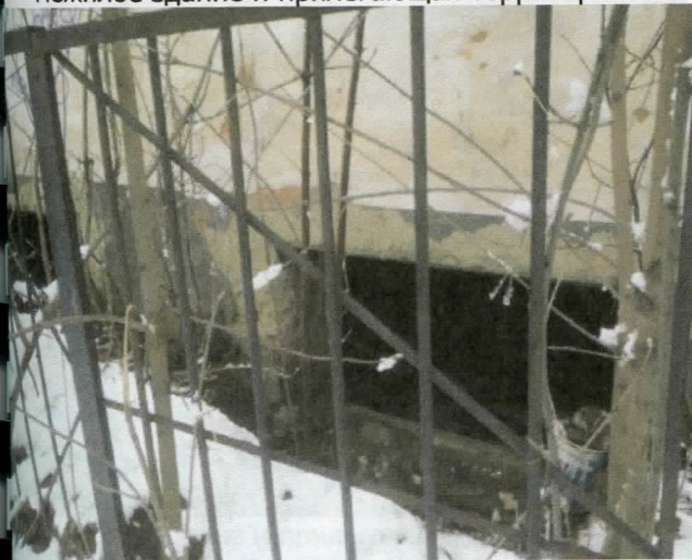
Нежилое здание и прилегающая территория
