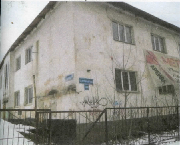
Нежилое здание и прилегающая территория
