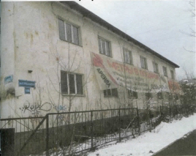
Нежилое здание и прилегающая территория
