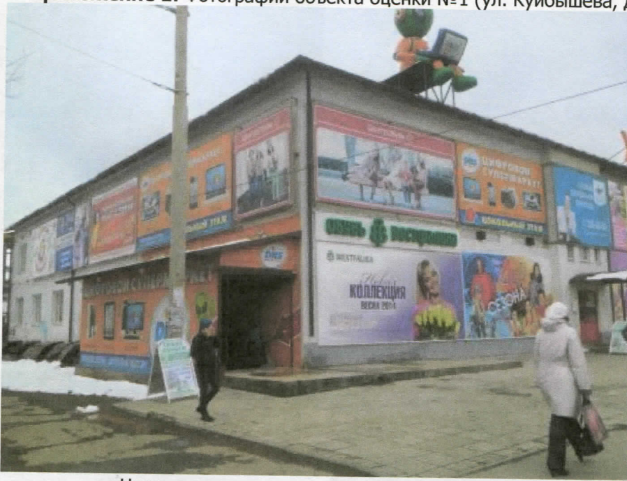
Нежилое здание и прилегающая территория
