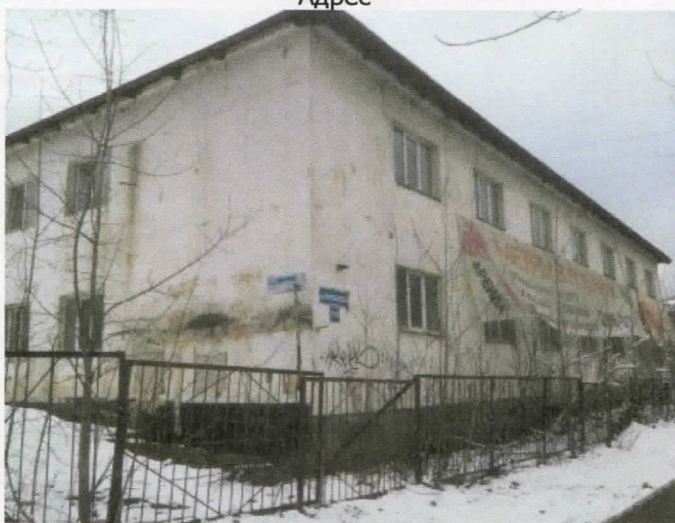
Нежилое здание и прилегающая территория
