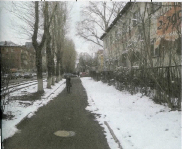
Нежилое здание и прилегающая территория
