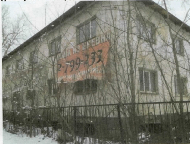
Нежилое здание и прилегающая территория
