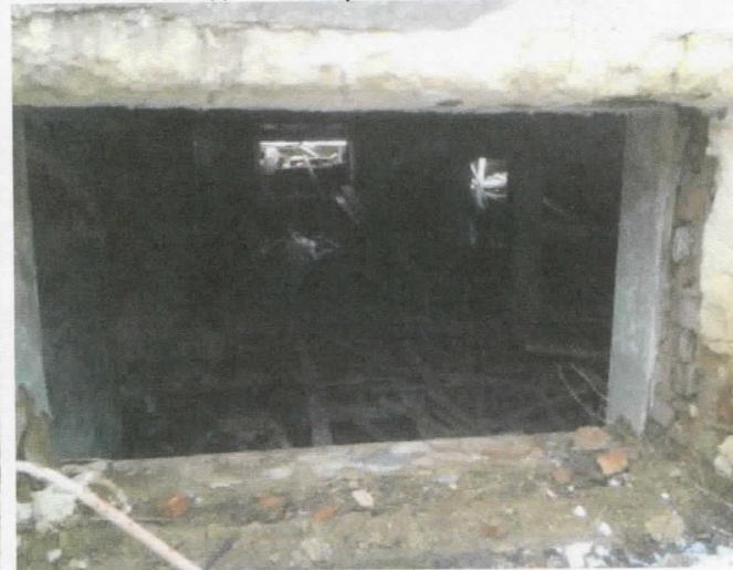
Нежилое здание и прилегающая территория
