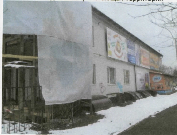
Нежилое здание и прилегающая территория
