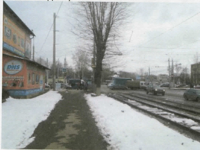
Нежилое здание и прилегающая территория
