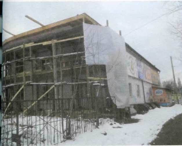
Нежилое здание и прилегающая территория
