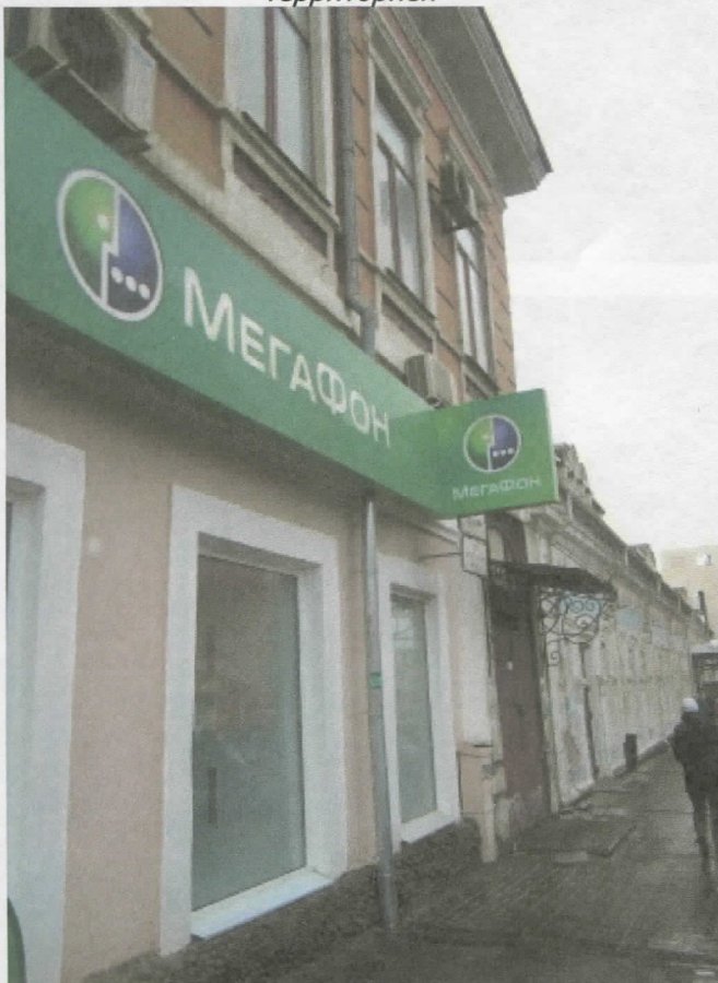
Административное здание с прилегающей территорией
