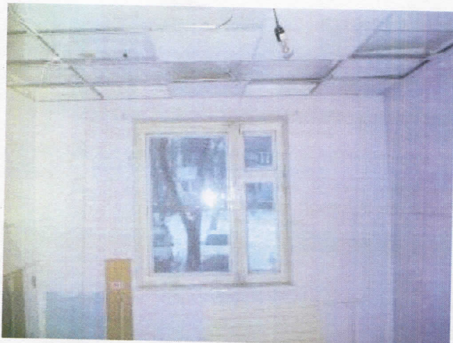
Фото 9-10. Общий вид помещения (№6)
