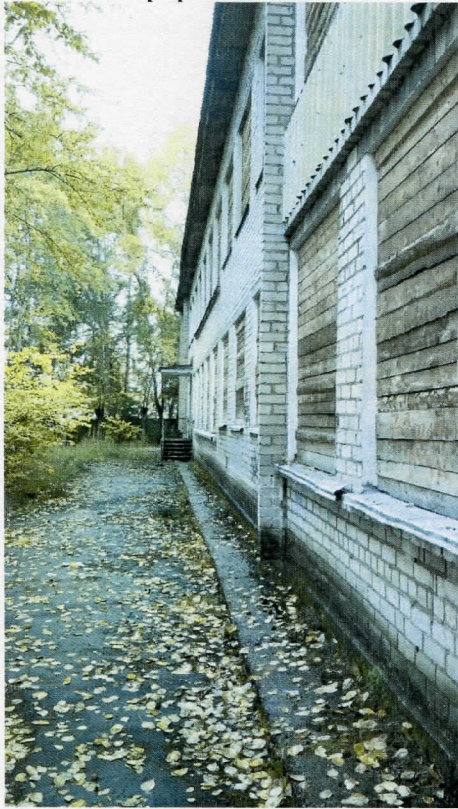
Фотография 7: Общий вид.
