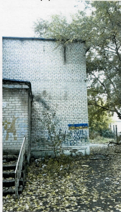
Фотография 8: Общий вид.
