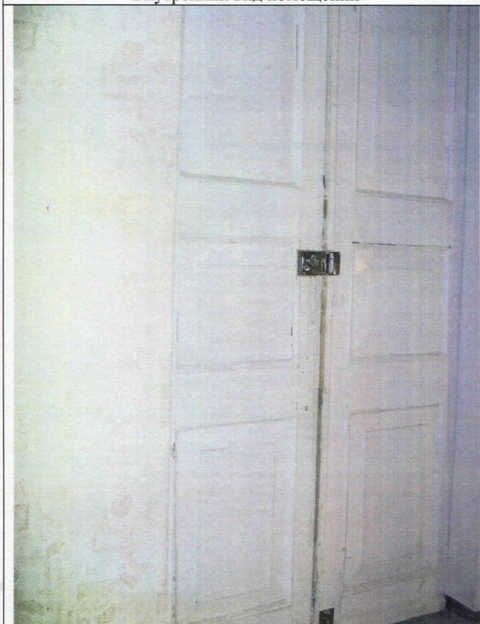
Внутренний вид помещений
