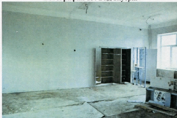
Фотография 13: Вид внутри.
