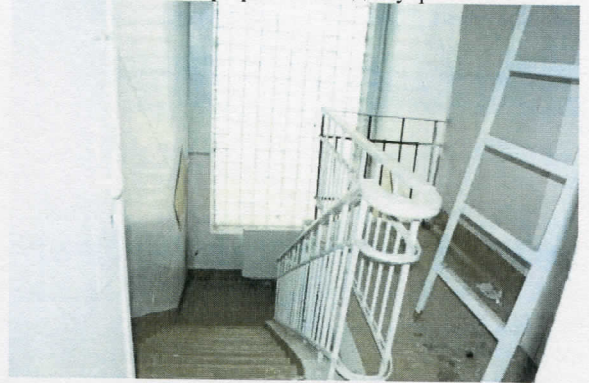
Фотография 18: Вид внутри.
