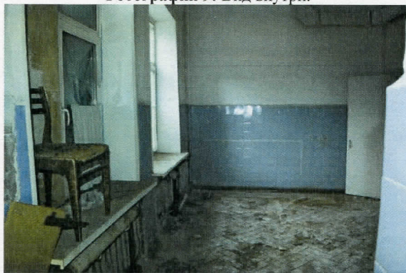
Фотография 9: Вид внутри.
