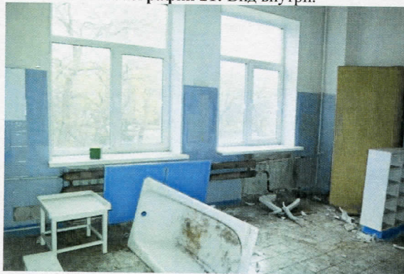
Фотография 21: Вид внутри.
