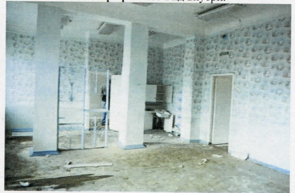
Фотография 20: Вид внутри.
