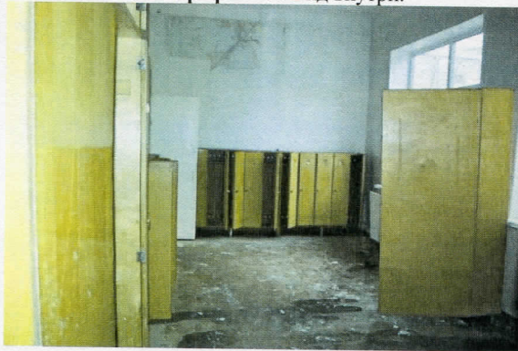
Фотография 19: Вид внутри.
