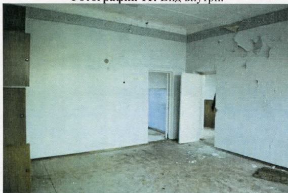
Фотография 11: Вид внутри.
