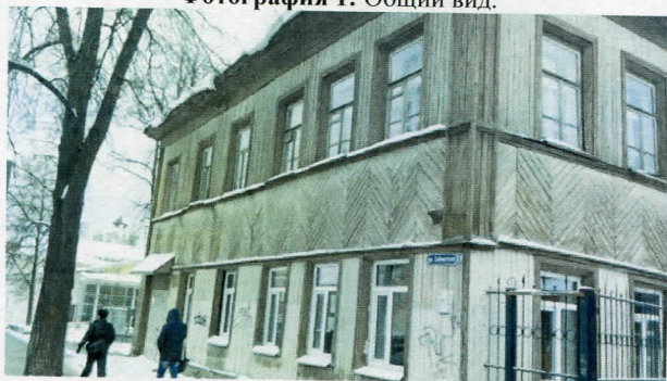
Фотография 1: Общий вид.
