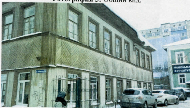
Фотография 3: Общий вид.
