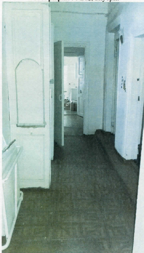
Фотография 9: Вид внутри.
