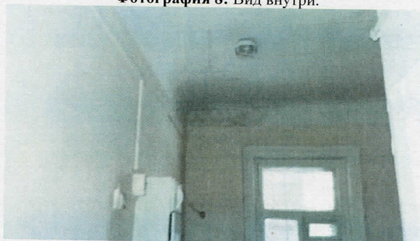
Фотография 8: Вид внутри.
