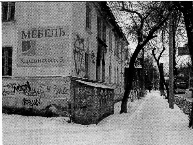
Общий вид на дом с входом в подвал во 2-ю часть
