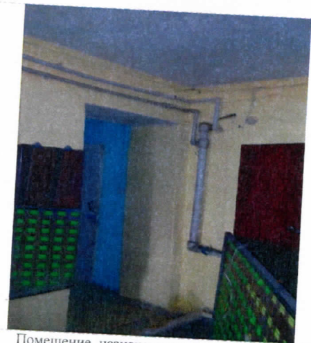
Помещение, назначение: нежилое помещение, общая площадь 32,8 кв. м., этаж: подвал, адрес местонахождение объекта: Пермский край, г. Пермь, Орджоникидзевский район, ул. Барнаульская, д.10.
