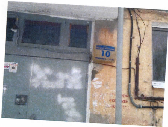
Помещение, назначение: нежилое помещение, общая площадь 32,8 кв. м., этаж: подвал, адрес местонахождение объекта: Пермский край, г. Пермь, Орджоникидзевский район, ул. Барнаульская, д.10.
