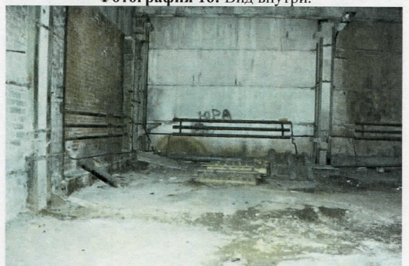
Фотография 16: Вид внутри.
