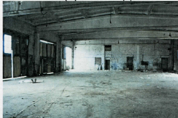
Фотография 32: Вид внутри.
