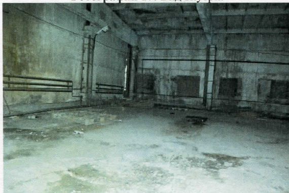
Фотография 17: Вид внутри.
