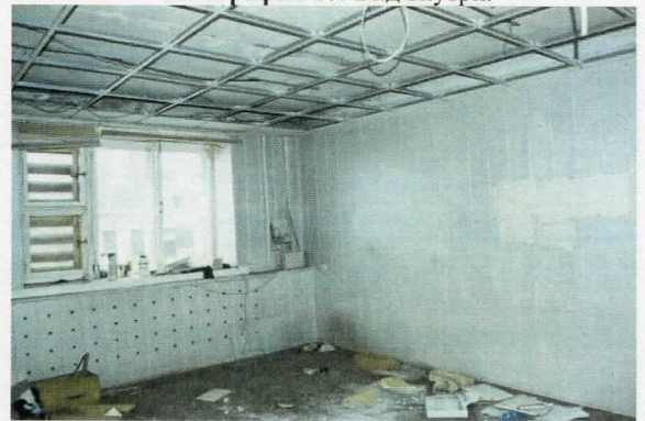
Фотография 10: Вид внутри.
