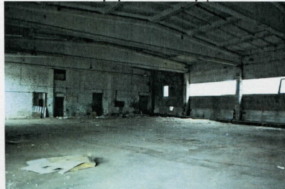
Фотография 31: Вид внутри.
