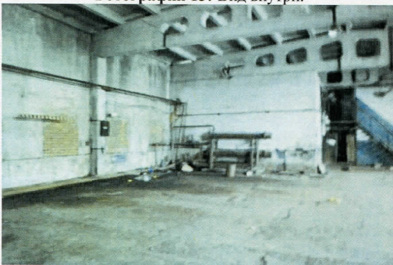
Фотография 13: Вид внутри.
