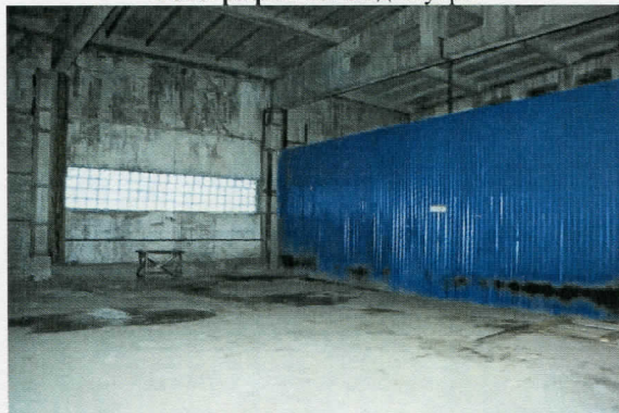
Фотография 18: Вид внутри.
