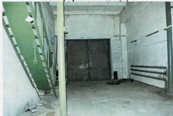
Фотография 20: Вид внутри.
