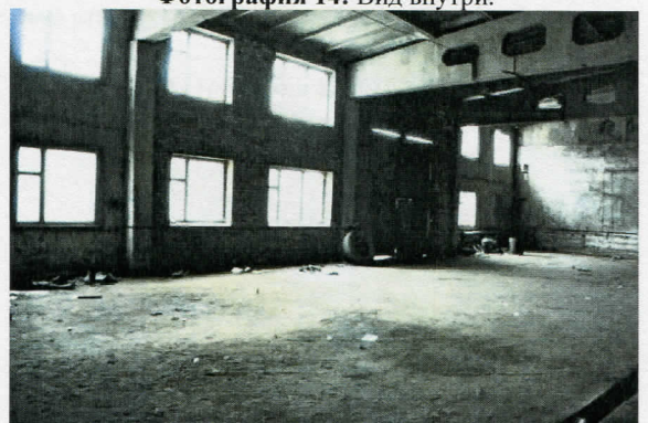
Фотография 14: Вид внутри.
