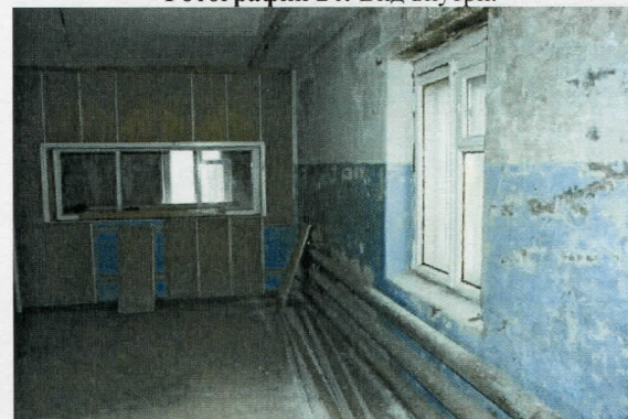
Фотография 24: Вид внутри.
