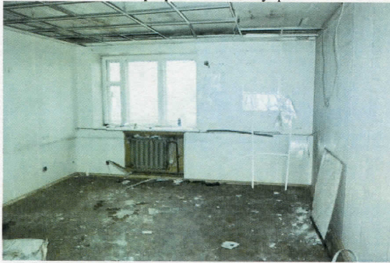
Фотография 9: Вид внутри.
