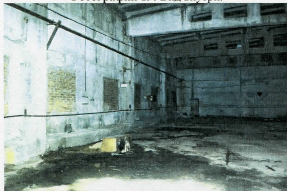
Фотография 19: Вид внутри.
