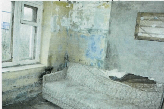
Фотография 26: Вид внутри.
