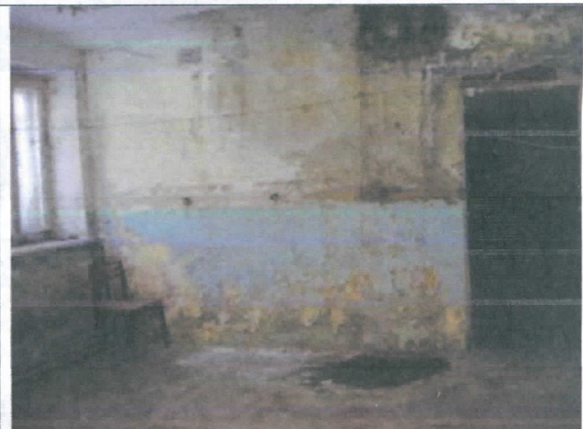
Общий вид х помещений
