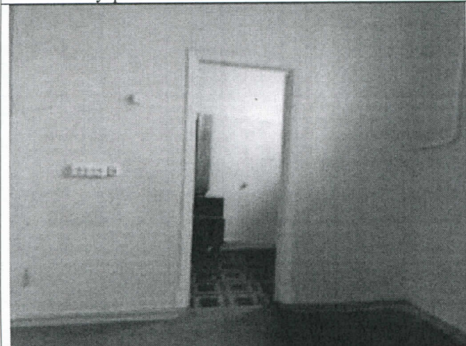
Внутренний вид помещений №1-6, 13-16
