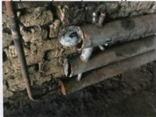
Фотография 41 Разрывы сварных швов труб отопления
