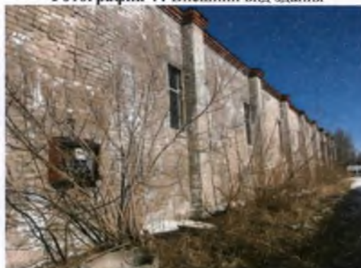
Фотография 44 Внешний вид здания
