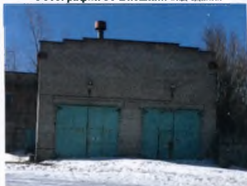
Фотография 50 Внешний вид здания
