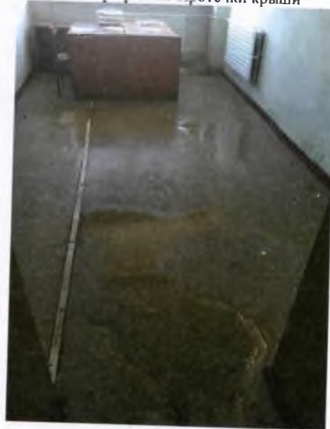
Фотография 18 Протечки крыши
