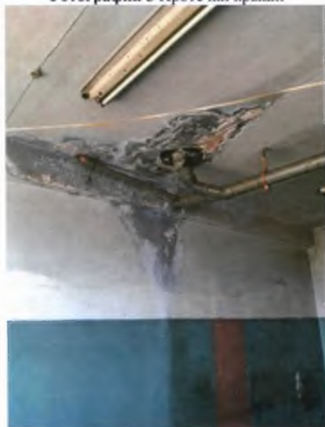
Фотография 5 Протечки крыши
