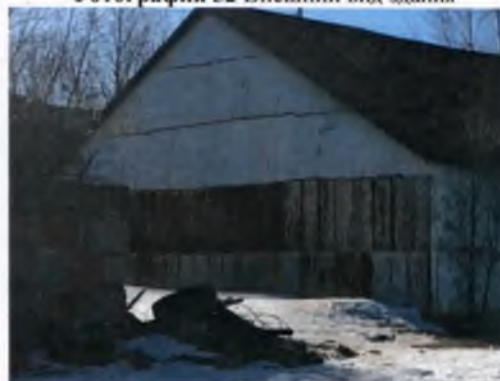
Фотография 52 Внешний вид здания
