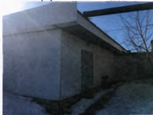
Фотография 68 Внешний вид здания
