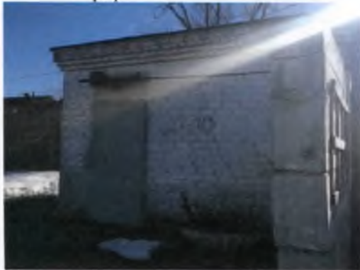
Фотография 59 Внешний вид здания
