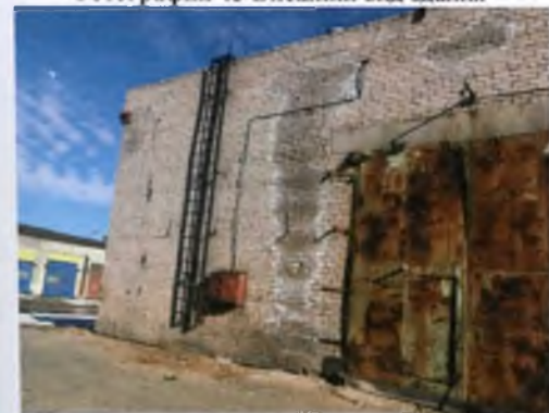
Фотография 43 Внешний вид здания
