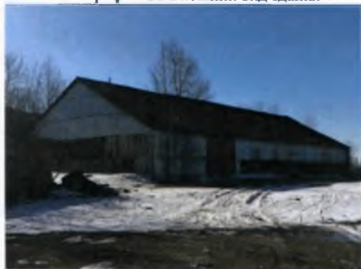
Фотография 51 Внешний вид здания
