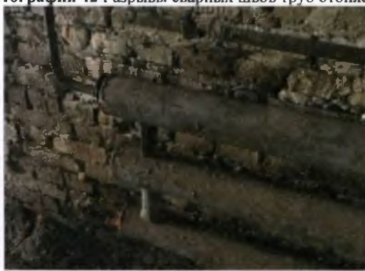
Фотография 42 Разрывы сварных швов труб отопления
