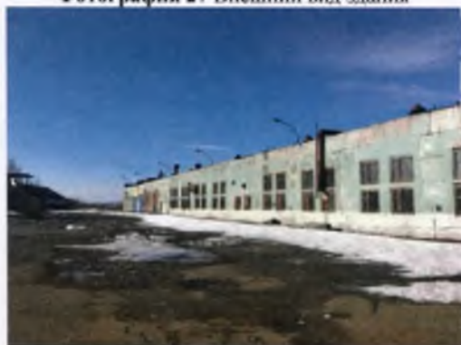
Фотография 27 Внешний вид здания
