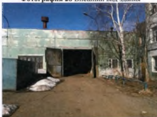
Фотография 28 Внешний вид здания
