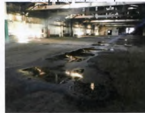
Фотография 36 Протечки крыши
