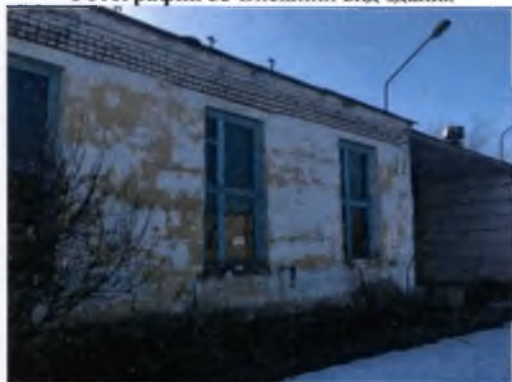
Фотография 53 Внешний вид здания
