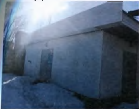
Фотография 67 Внешний вид здания
