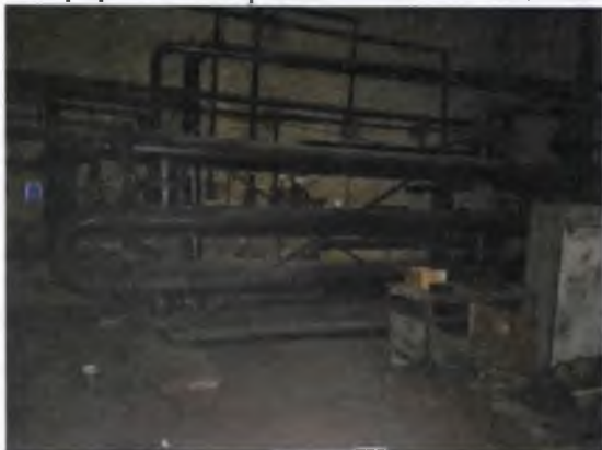
Фотография 77 Бойлер диам. 219 мм 5-ти секционный
