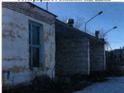
Фотография 54 Внешний вид здания
