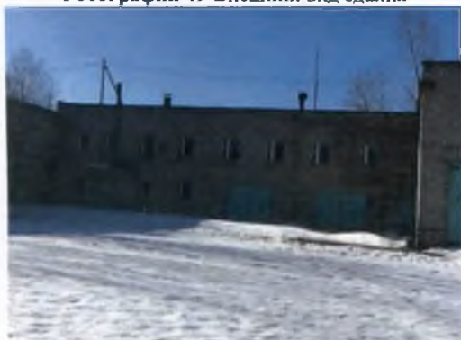
Фотография 49 Внешний вид здания
