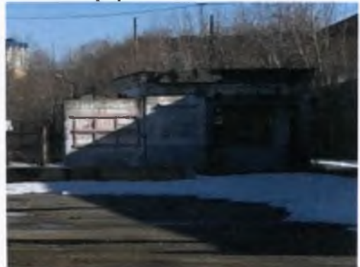
Фотография 60 Внешний вид здания
