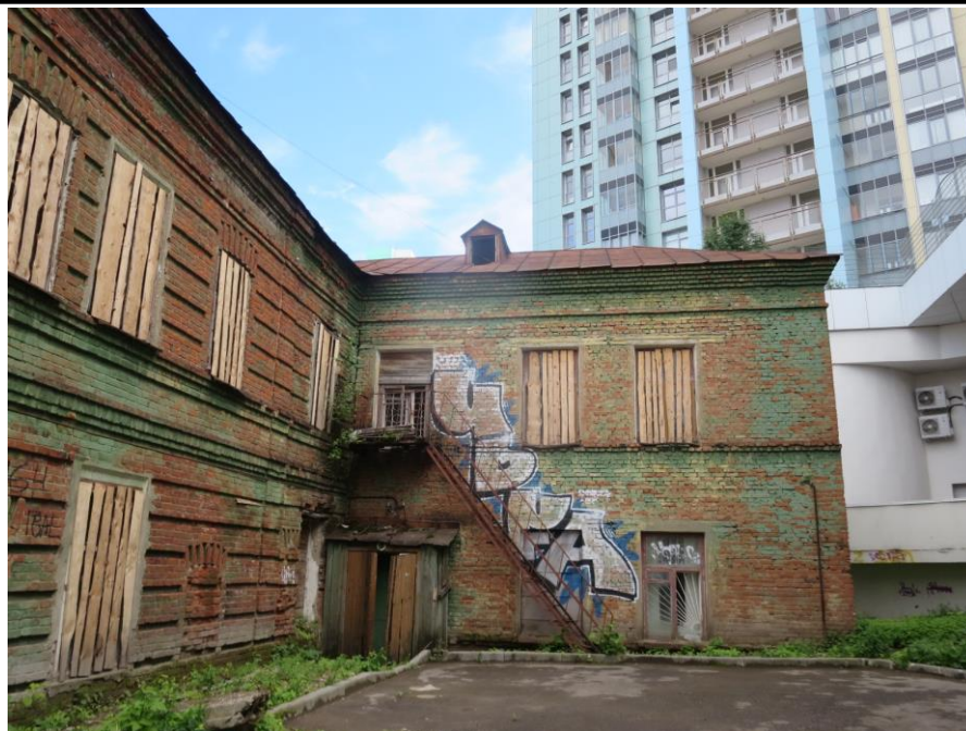
Фото 16. г. Пермь, ул. 25 Октября, 47. «Дом Грацинского». Дворовой фасад. Заложенные, закрытые оконные проемы.
