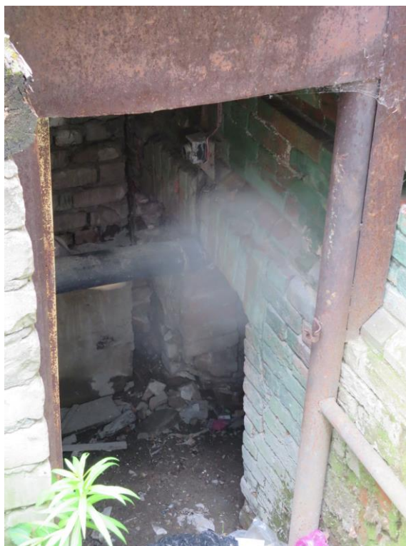
Фото 6. г. Пермь, ул. 25 Октября, 47. «Дом Грацинского». Вход в техподполье.
