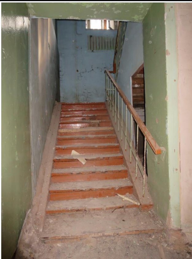
Фото 28 г. Пермь, ул. 25 Октября, 47. «Дом Грацинского». Интерьер. Первый этаж. Помещение 7. Ветхая, деревянная лестница.
