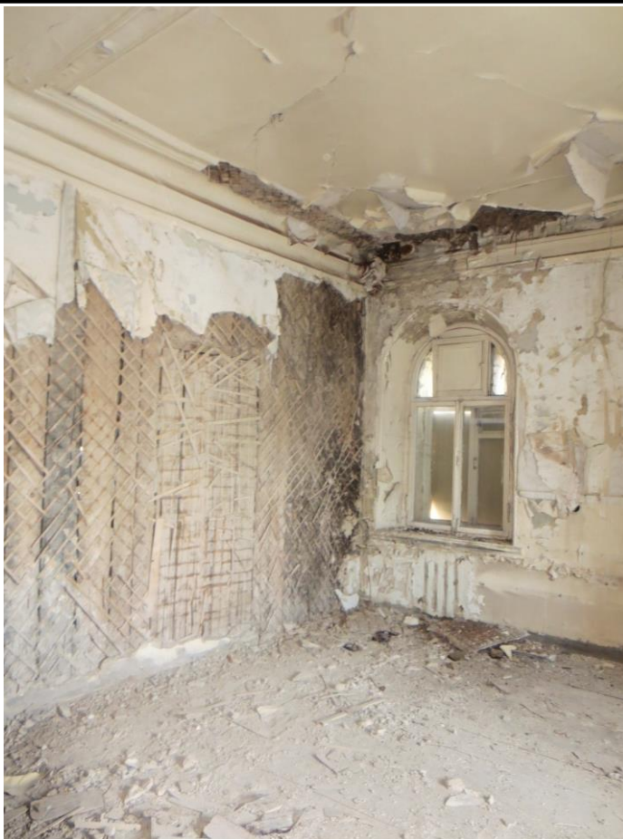
Фото 30 г. Пермь, ул. 25 Октября, 47. «Дом Грацинского». Интерьер. Второй этаж. Помещение 16. Разрушение потолочного профилированного карниза. Отслаивание покрасочного, штукатурного слоев.
