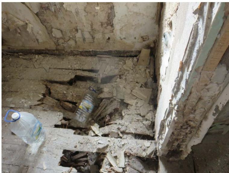
Рис. 2.1. Вскрытие перекрытия 1 этажа, №10 перекрытия.
