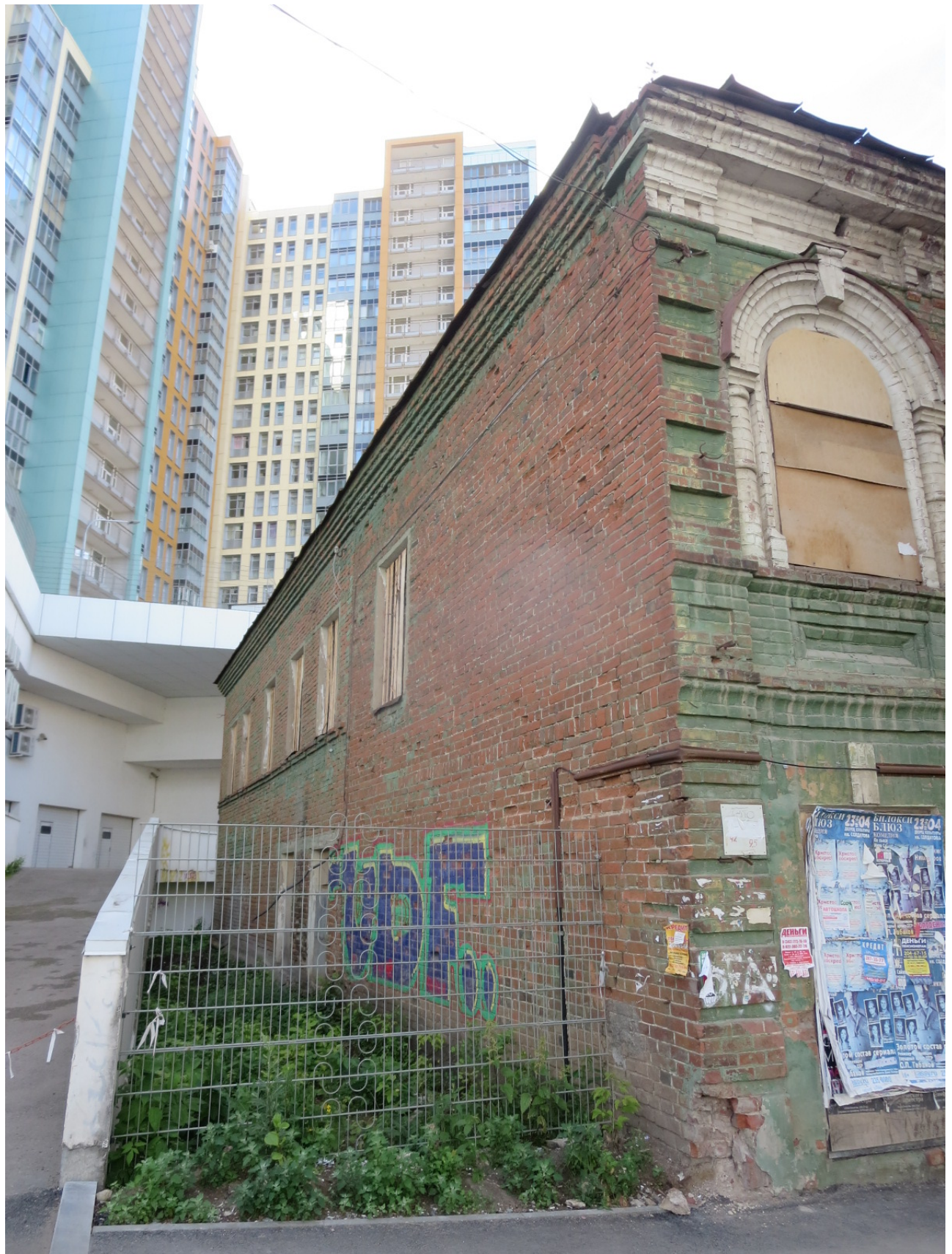
Рисунок 1.3. Фасад здания со стороны ул. Революции
