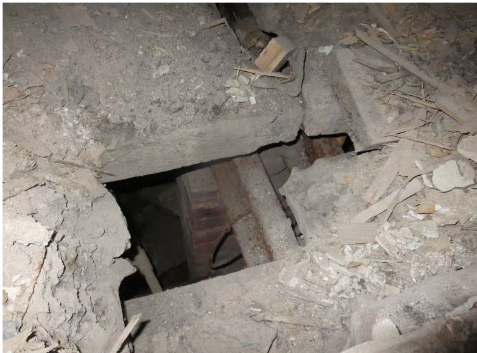
Рис. 2.2. Вскрытие полов в помещении 1 этажа №20 перекрытия техэтажа .
