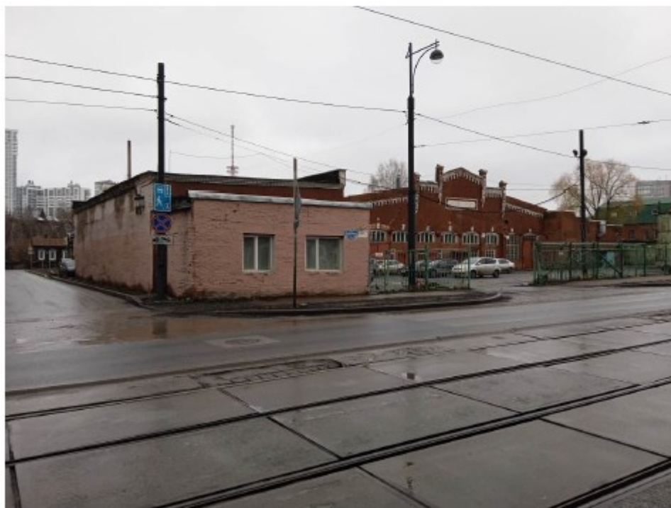
Общий вид с юго-запада.
