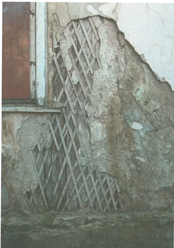
Фото №№ 1-3. Разрушение фундаментов, штукатурных слоёв Раскрашивание, отслоение кирпичной кладки фундаментов и штукатурных слоёв
