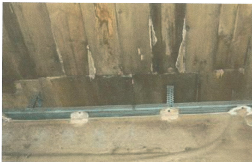
Фото №№ 19-22. Разрушение отделки, штукатурных слоёв потолков, стен. Биоповреждение древесины стен и перекрытий. Разрушение трубопроводов и отсутствие радиаторов отопления
