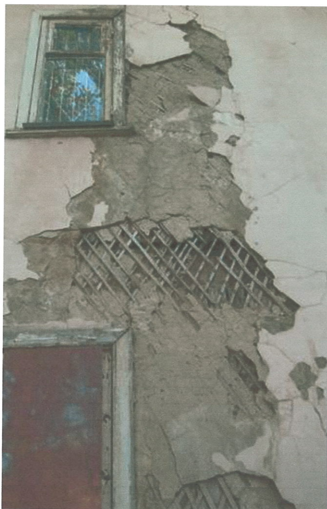
Фото №№ 1-3. Разрушение фундаментов, штукатурных слоёв Раскрашивание, отслоение кирпичной кладки фундаментов и штукатурных слоёв
