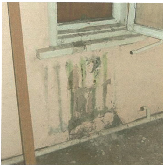
Фото №№ 19-22. Разрушение отделки, штукатурных слоёв потолков, стен. Биоповреждение древесины стен и перекрытий. Разрушение трубопроводов и отсутствие радиаторов отопления
