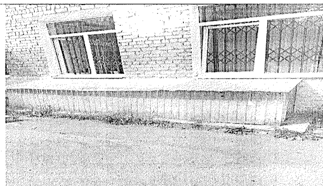
Вход в подвал (приямок с навесом)
