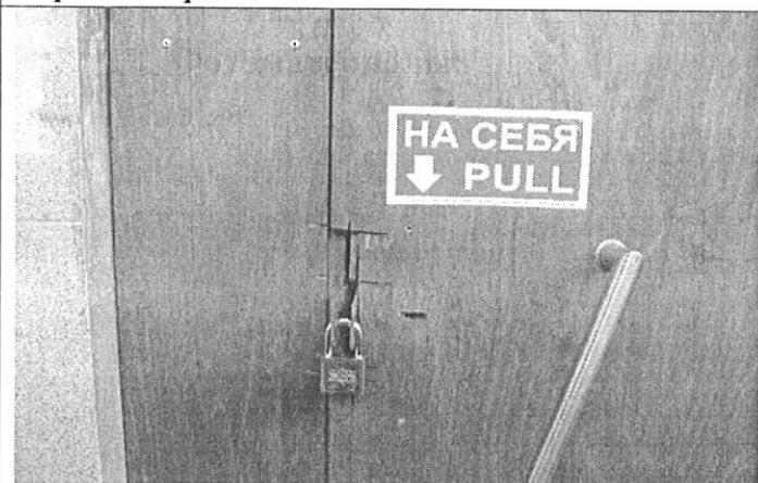
Входная дверь в подвал
