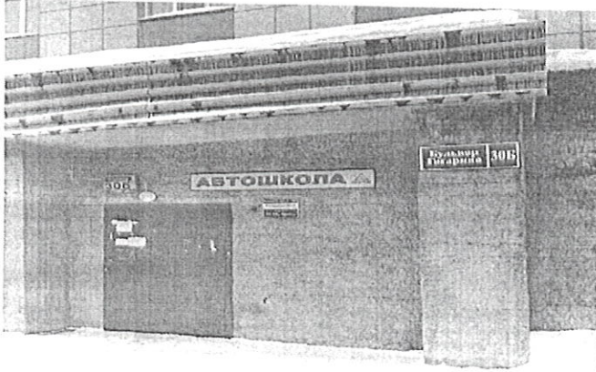
Вход в помещение
