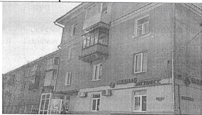
Фасад здания (адресная привязка)
