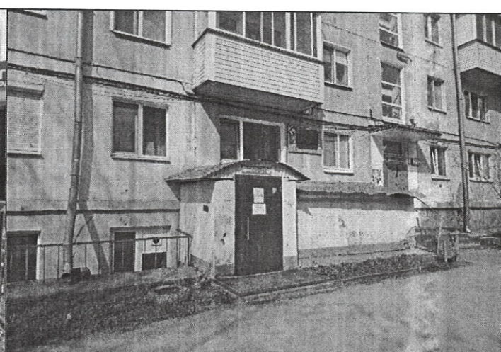
Вход на объект между 1 и 2 подъездами.
