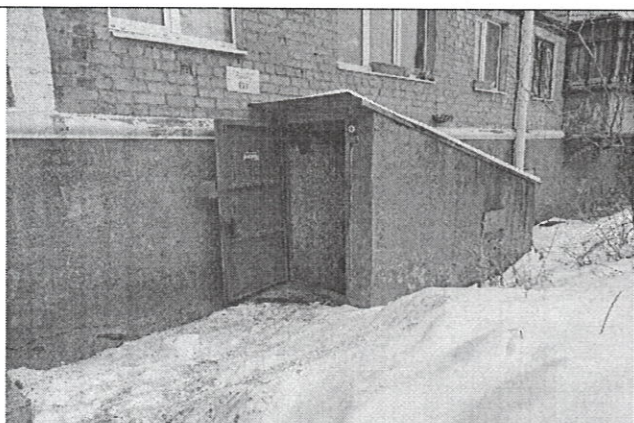
Вход в подвал (через пристрой-прямую)
