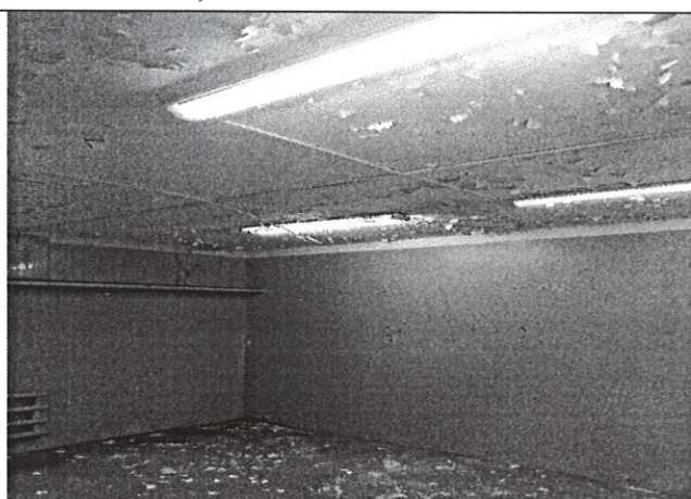
Пом. № 17 по ТП от 23.12.2024
