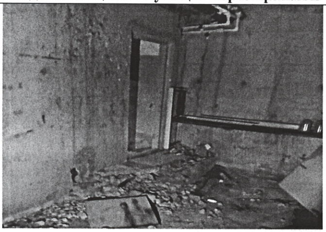
Пом. № 28 по ТП от 23.12.2024
