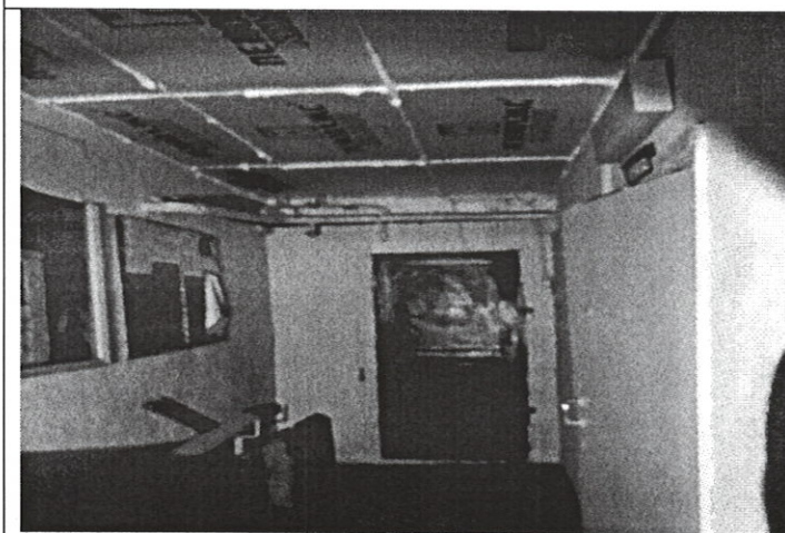
Пом. № 10 по ТП от 23.12.2024
