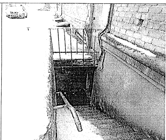
Вход в помещение со двора через приямок
