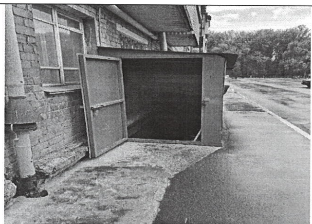
Пристрой – приямок (вход в подвал)
