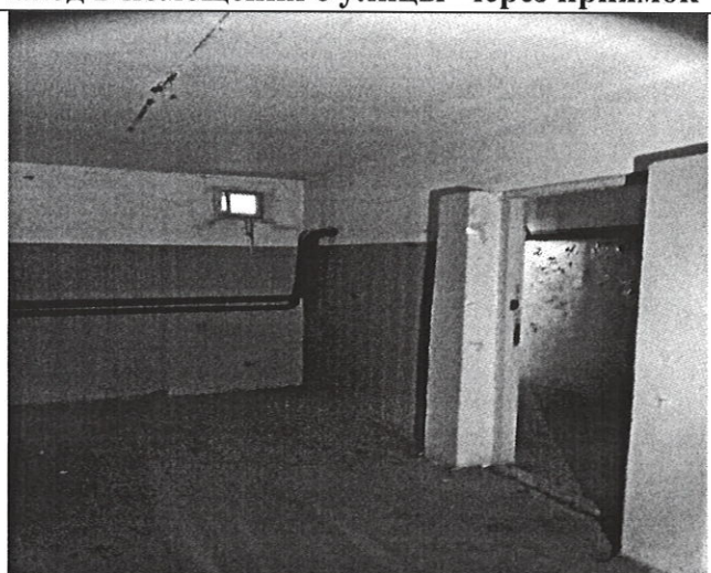
Пом. № 21 по ТП от 23.12.2024
