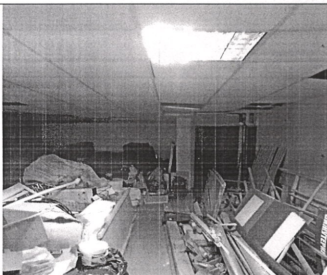
Пом. № 12 по ТП от 23.09.2022
