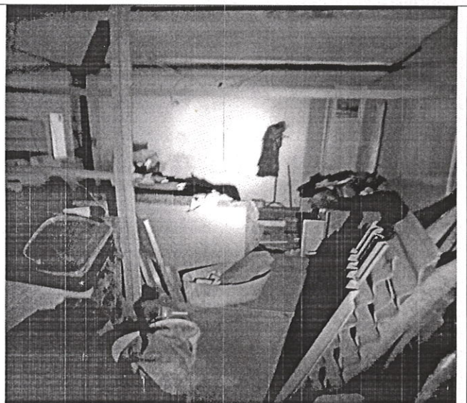
Пом. № 16 по ТП от 23.09.2022
