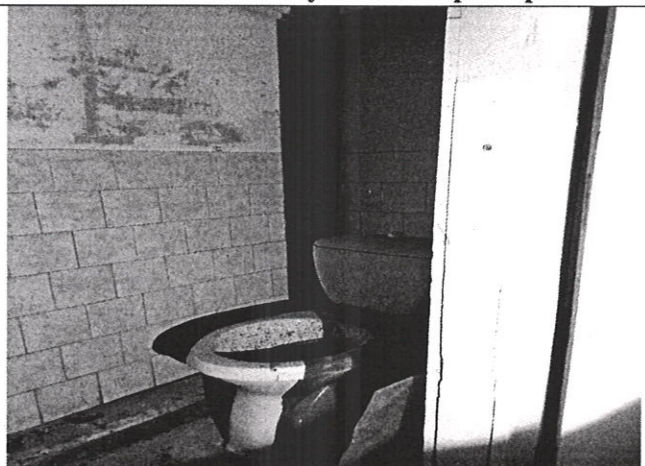
Пом. № 8 туалет по ТП от 23.12.2024
