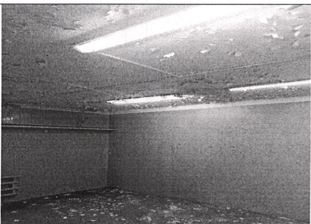
Пом. № 17 по ТП от 23.12.2024
