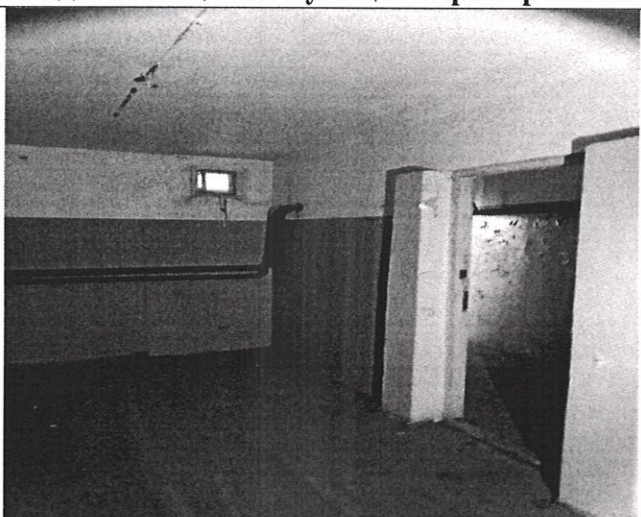
Пом. № 21 по ТП от 23.12.2024
