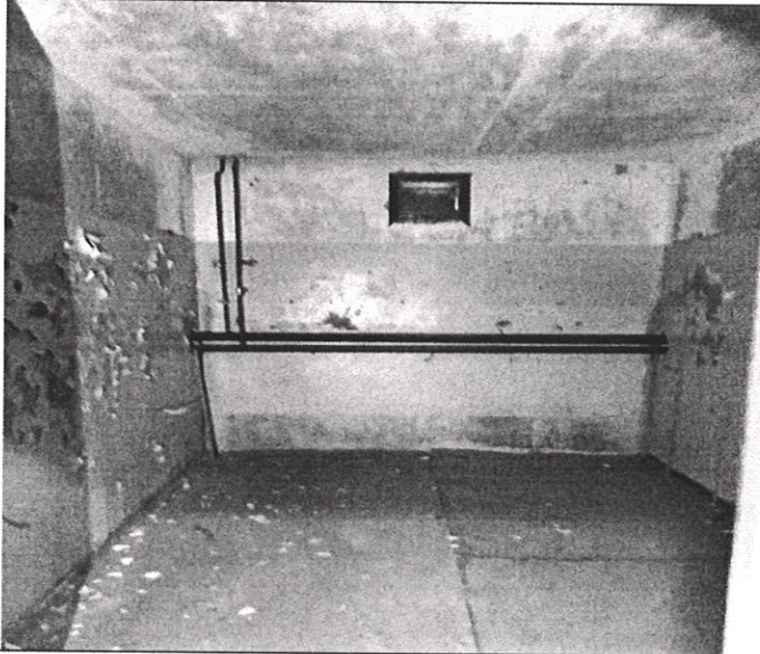
Пом. № 26 по ТП от 23.12.2024
