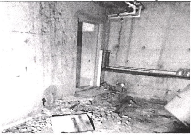
Пом. № 28 по ТП от 23.12.2024
