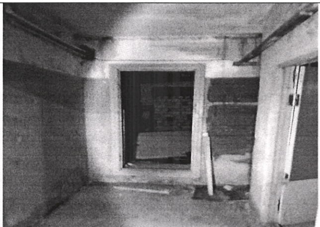
Пом. № 29 коридор по ТП от 23.12.2024
